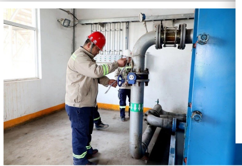
开展磨机检修 维护设备安全
